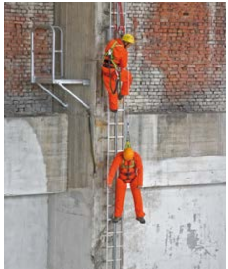
Abb. 10 Rettung einer verunfallten Person von einer Steigschutzeinrichtung
