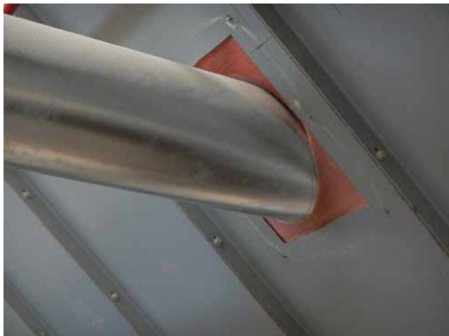
c) Anschluss des Absaugstutzens an die Entsorgungswanne
