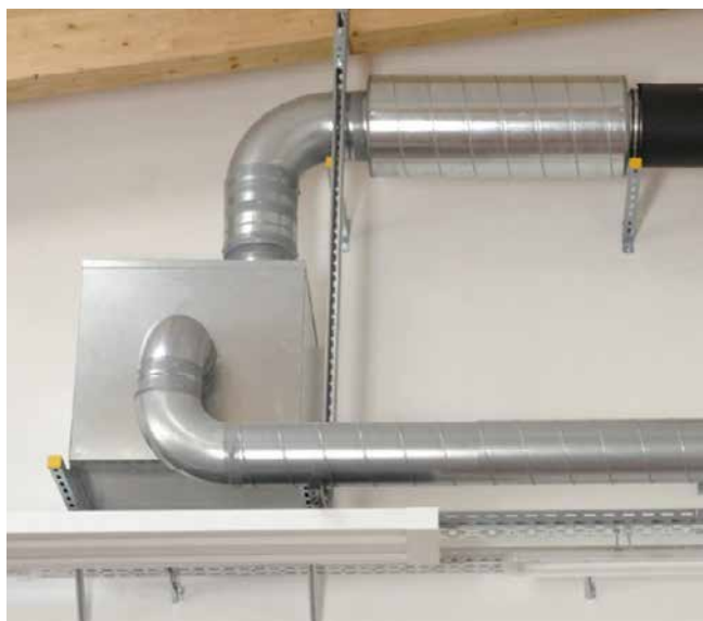
Abb. 46a + b Ausführung einer Schallschutzhaube für einen Ventilator
