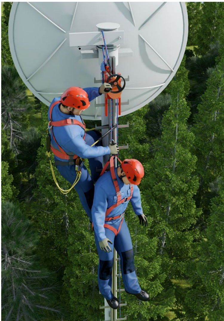
Abb. 7 Rettung einer Person mit Höhenrettungsgerät
