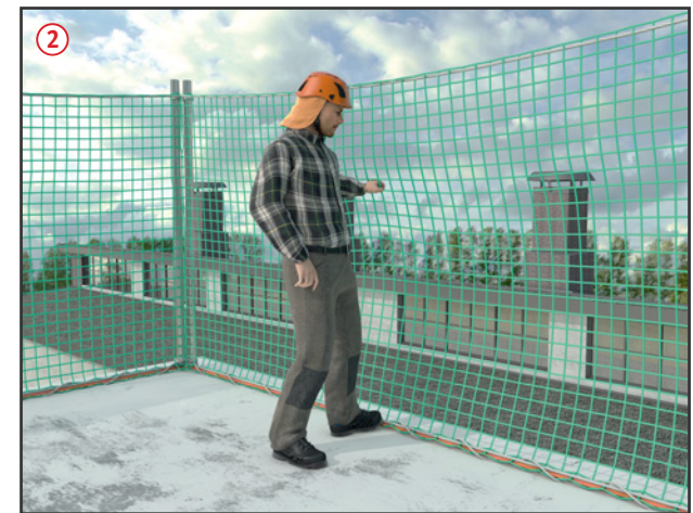
Randsicherung auf der Dachfläche
