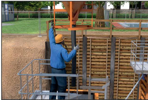
Beispiel für einen Industrieschutzhelm nach EN 397
