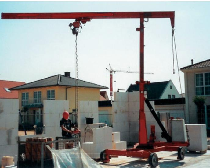
Da beim Vermauern von großformatigen Steinen Rückenbeschwerden entstehen können, ist der Einsatz von Versetzhilfen beim Vermauern großformatiger Steine zur Erhaltung der Gesundheit notwendig.
