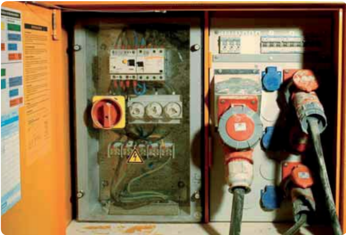
Baustromverteiler
