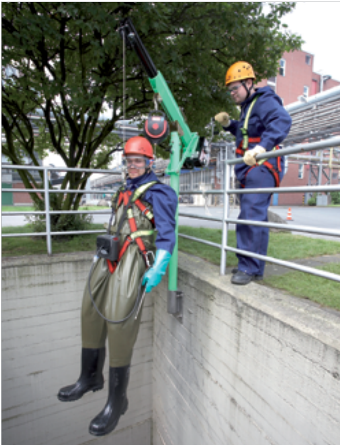
Abbildung 32: Einfahren in eine Abwassergrube
