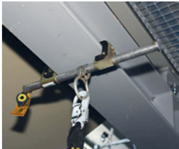
Abbildung 40: Trägerklemme
