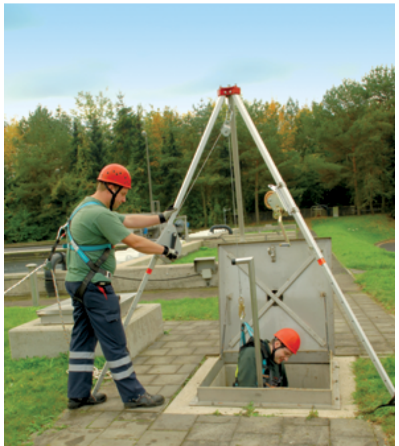
Abbildung 31: Rettung aus einem Schacht
