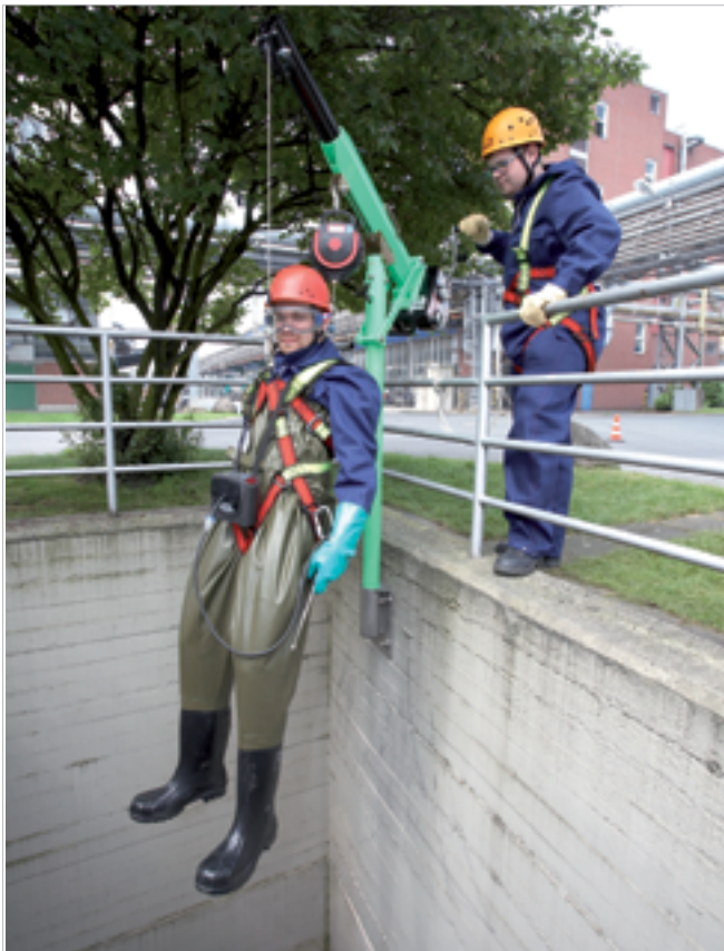
Abbildung 17: Einfahren in eine Abwassergrube
