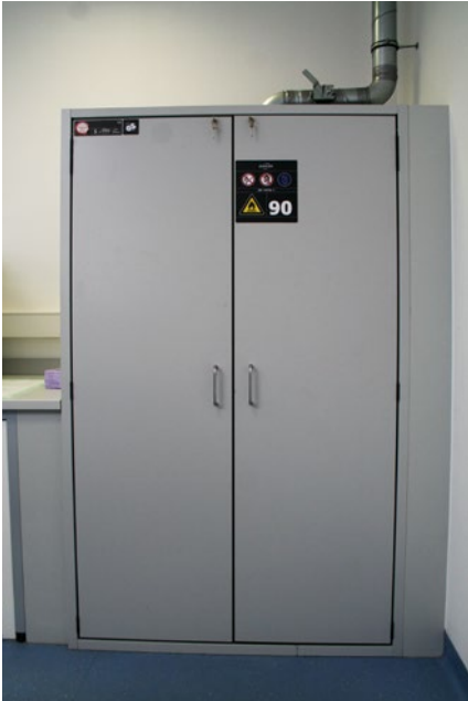
Abb. 17 Lagerung entzündbarer Flüssigkeiten im Sicherheits-schrank (explosionsgeschützte Lagerung)
