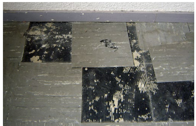
Abb. 11 Ausbau von asbesthaltigen Flexplatten
