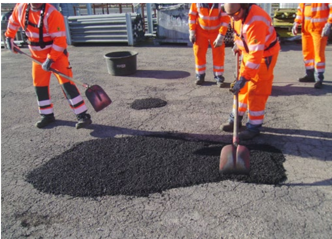
Abb. 7 Straßenausbesserungsarbeiten mit bitumenhaltigem Reparaturasphalt
