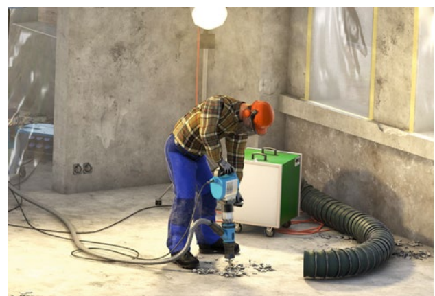
Abb. 13 und 14 Verwendung geprüfter, abgesaugter Bearbeitungssysteme
