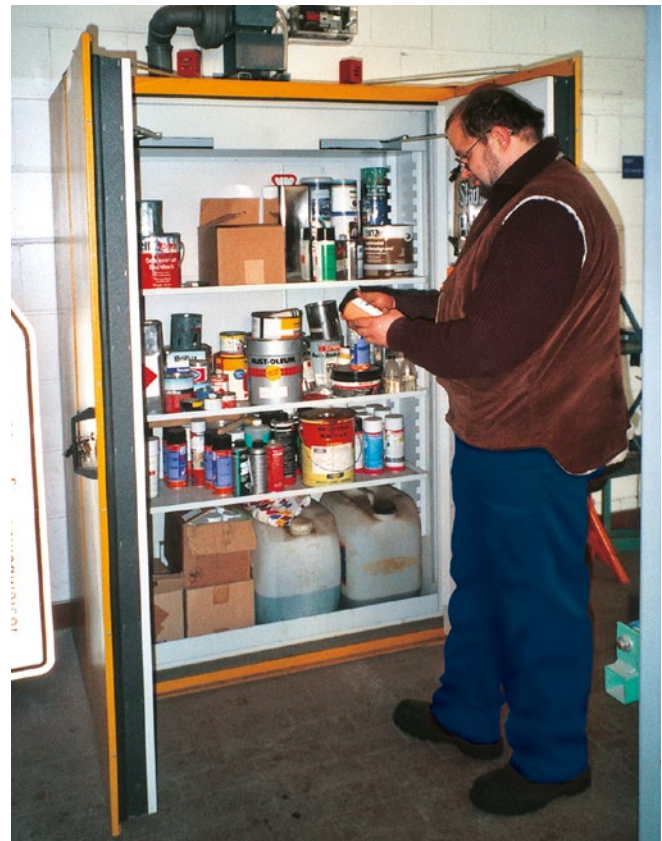
Abb. 2 Lagerung entzündbarer Flüssigkeiten in einem Sicherheitsschrank
