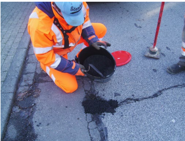
Abb.8 Kleinflächige Straßenausbesserungsarbeiten mit Reparaturasphalt
