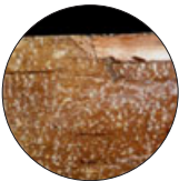
Holzschutzmittel im Dachstuhl
