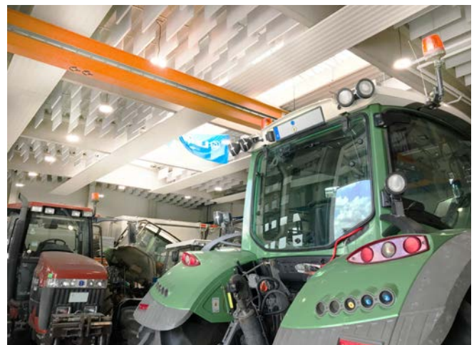
Abb. 37 Nachträglich mit Baffles raumakustisch verbesserte Werkstatt
