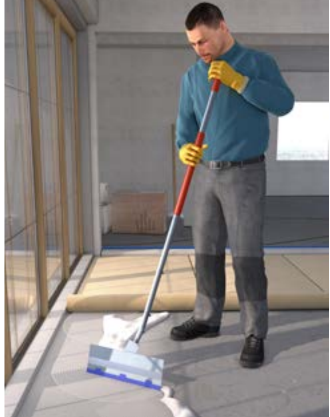
Abb. 20 Aufrechte Körperhaltung durch Einsatz von Teleskopstiel
