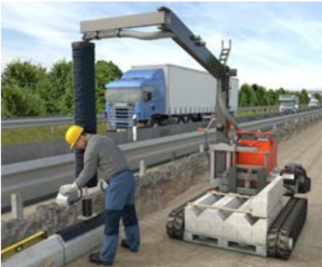
Abb. 14 Vakuump- und pneumatische Hebehilfen
