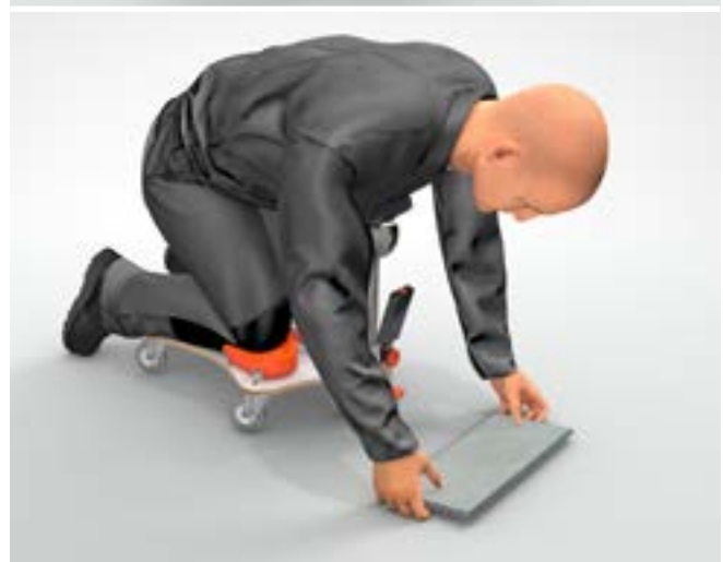
Abb. 21 Entlastung von Körper-Halterarbeit durch spezielle Arbeitshocker
