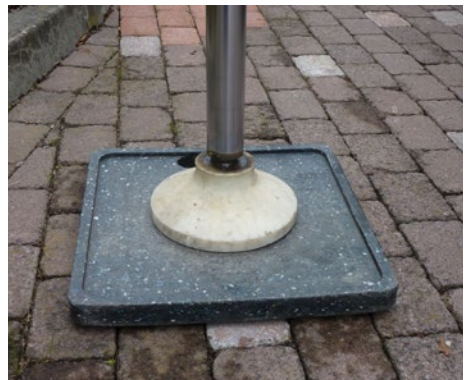
Bild 4-6 ausreichende Lastverteilung
