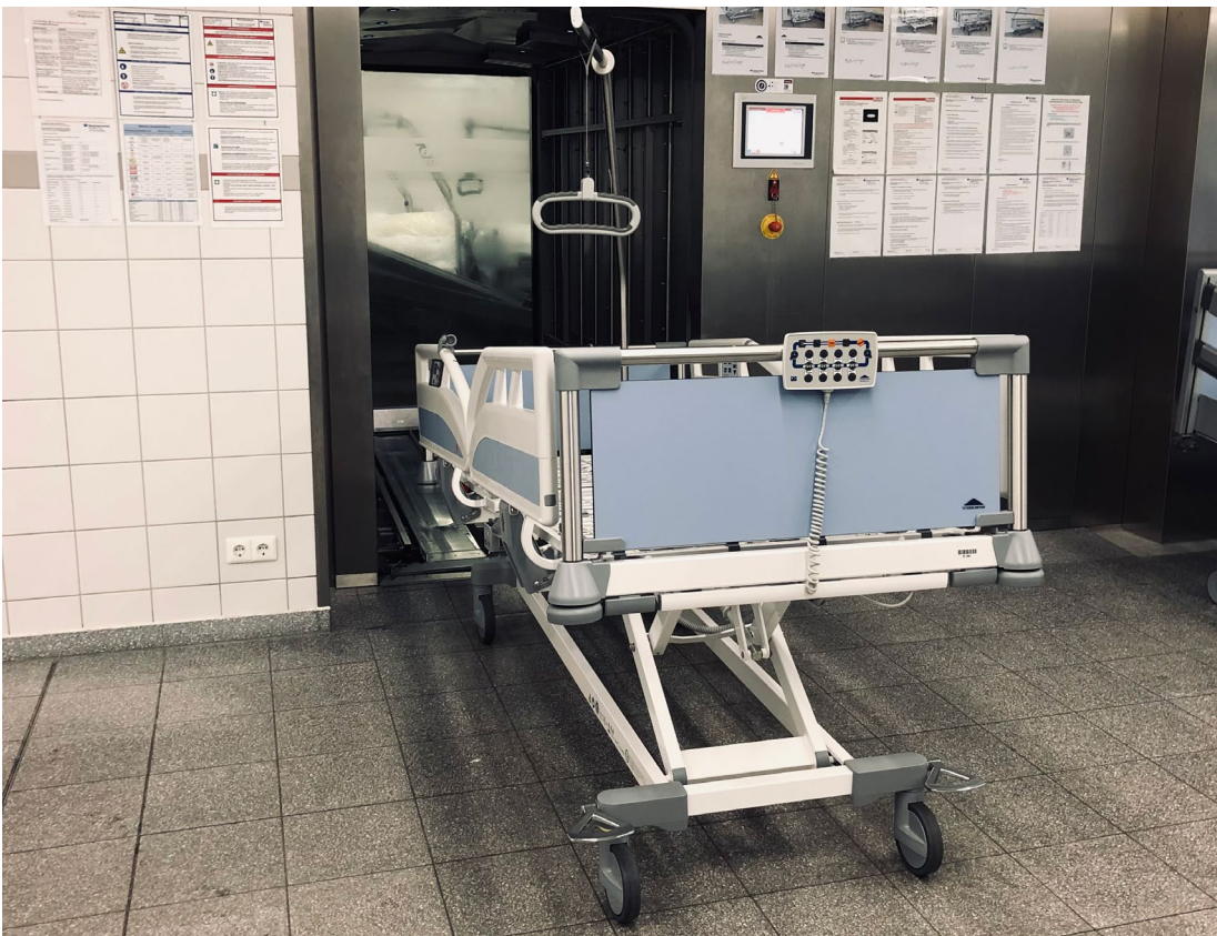
Abb. 12 Chemothermische maschinelle Bettendesinfektion in der Bettendesinfektionsanlage
