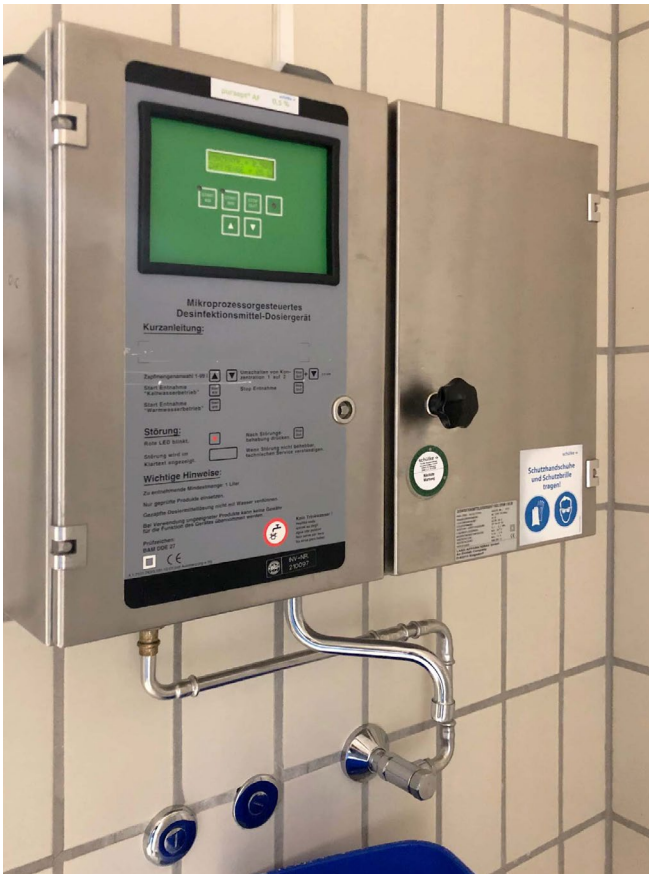
Abb. 5 Entnahme der verdünnten Anwendungslösung aus einem Dosierautomaten für die Desinfektion
