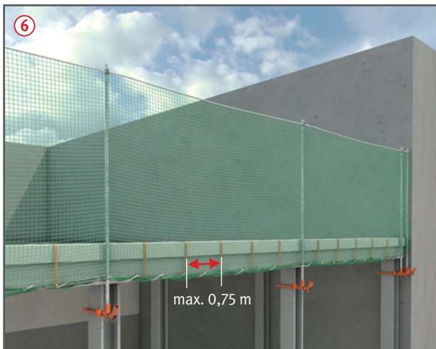
Randsicherung im unteren Bereich an Bauteilen befestigt.
